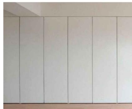
Los armarios serán empotrados en obra, mediante módulos de tablero de partículas de 16mm de espesor, con una barra interior para colgar ropa y un estante. Las puertas serán de DM lacadas en color blanco mate; del mismo modo, se ejecutarán las puertas de paso, lacadas a dos caras.
